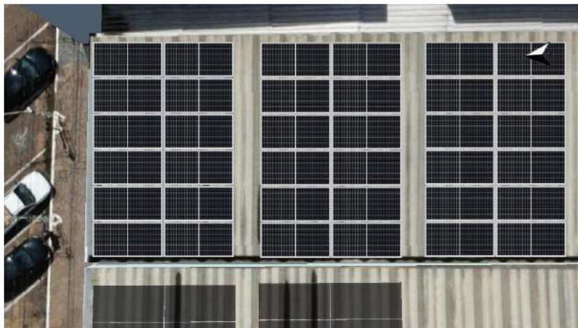
Figura 7: Montagem do telhado inclinado a oeste.
