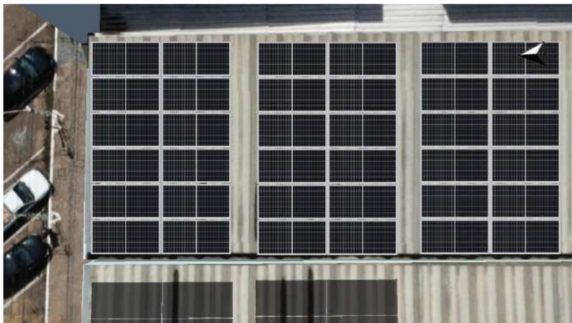
Figura 7: Montagem do telhado inclinado a oeste.
