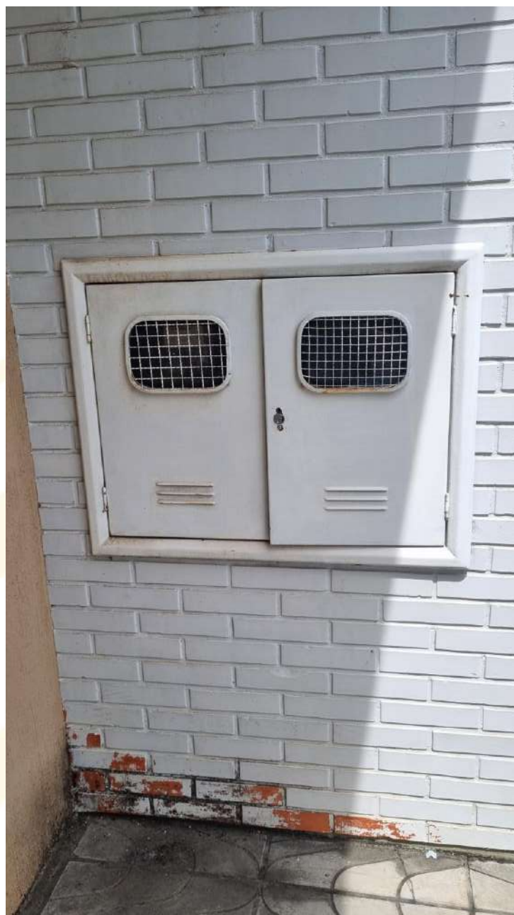
Figura 11: Padrão de entrada existente
